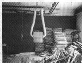
Die FRISE während des Umbaus
